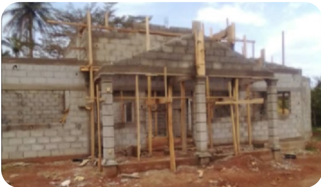
L'édifice du Centre Communautaire Polyvalent d'Ayos en chantier
