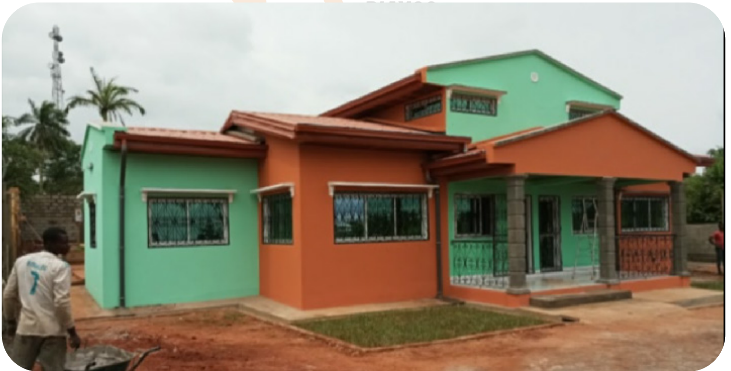
Finalisation du chantier du Centre Communautaire Polyvalent d'Ayos
