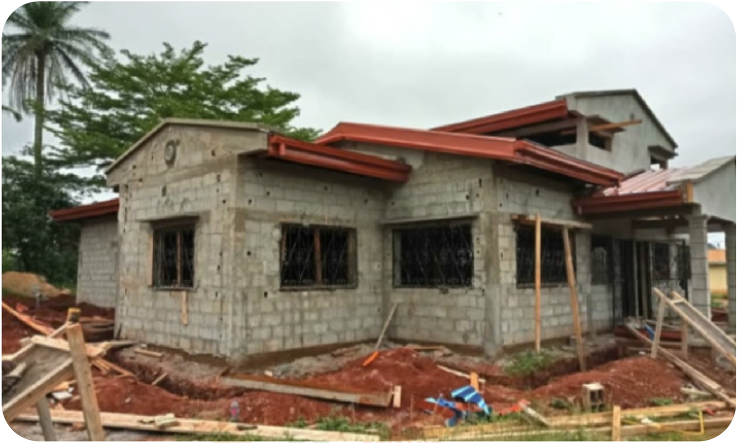
Evolution du chantier du Centre Communautaire Polyvalent d'Ayos
